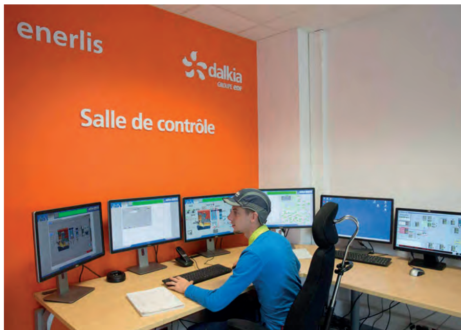
Les ordinateurs de la salle de contrôle permettent de surveiller tous les paramètres du réseau de chaleur.
