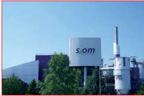
Au Siom, l'Unité de valorisation énergétique (UVE).
