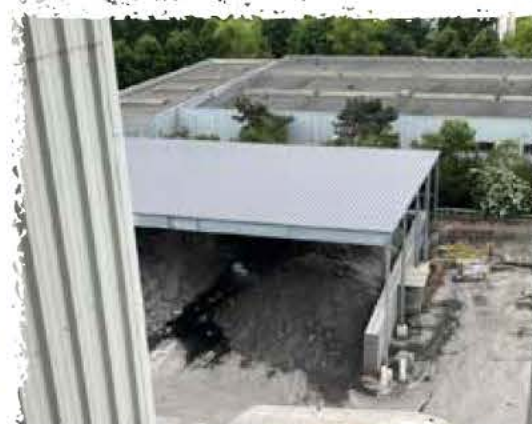
Nouvel auvent pour le stockage du mâchefer
